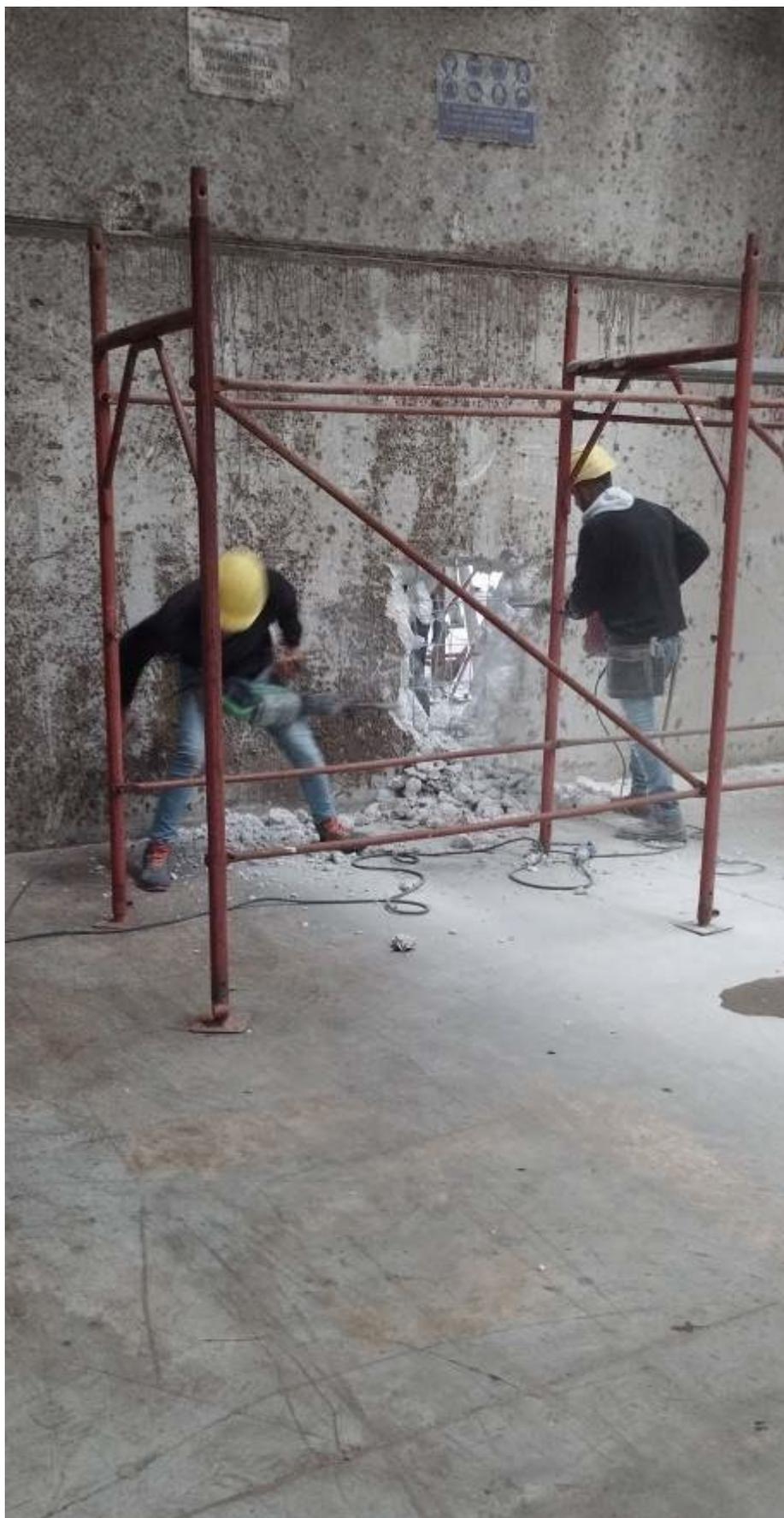
*Figura 24 - lavoro di demolizione effettuato dalla parte interna*
