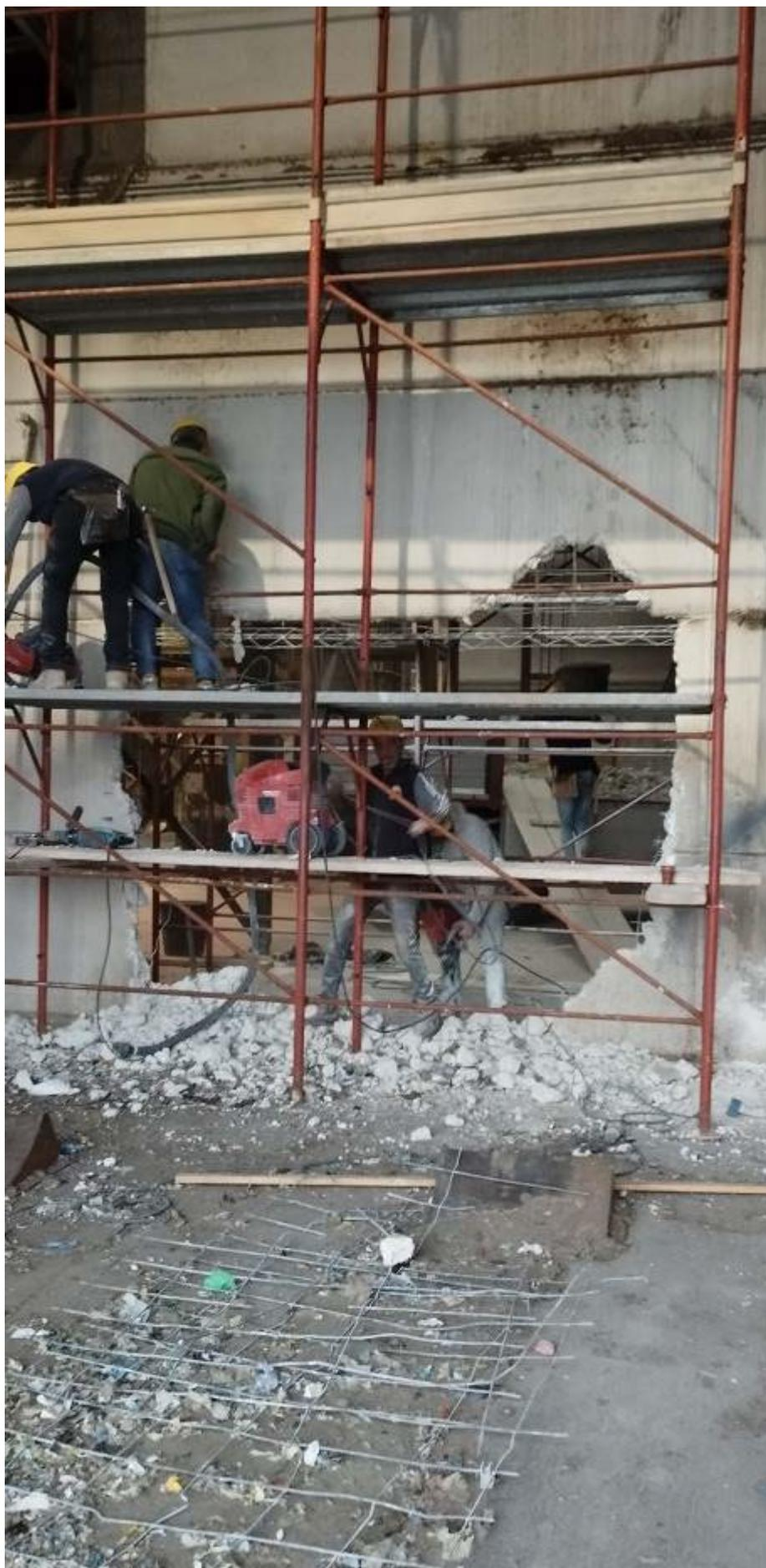
Figure nn. 26-27-28 mostrano i lavori di demolizione parte sia dall'interno che dall'esterno
