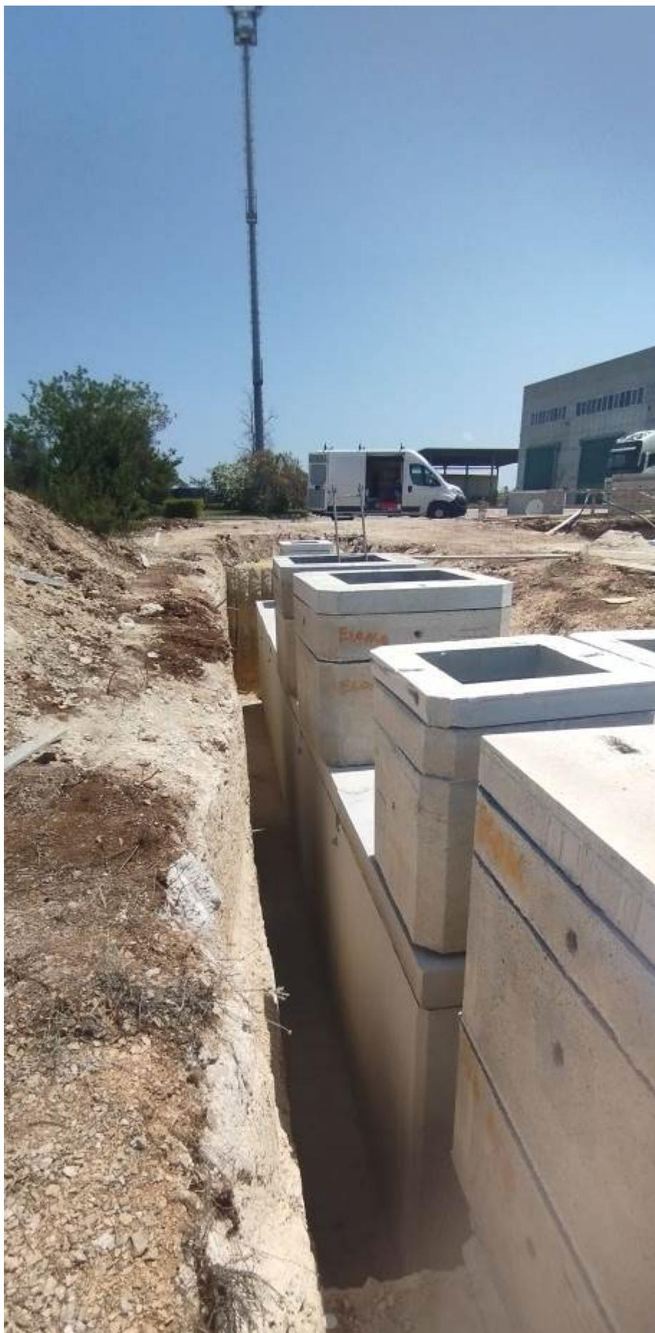
*Figure nn.54-55-56-57-58-59-60-61-62-63 mostrano le varie fasi dei lavori di posizionamento delle vasche e dei pozzetti*
