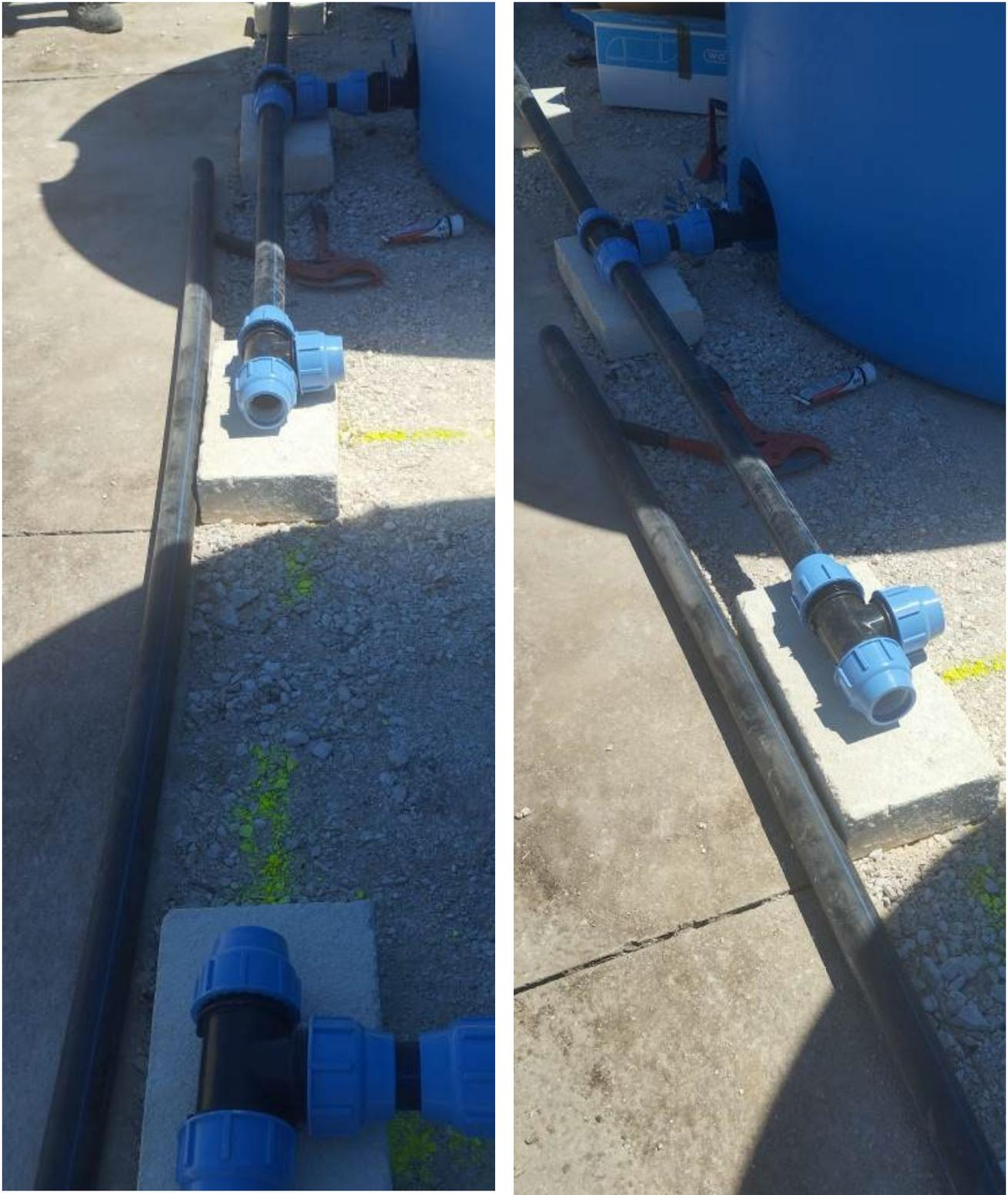
*Figure nn.45-46-47-48 mostrano il posizionamento definitivo dei serbatoi e collegamento idrico*
