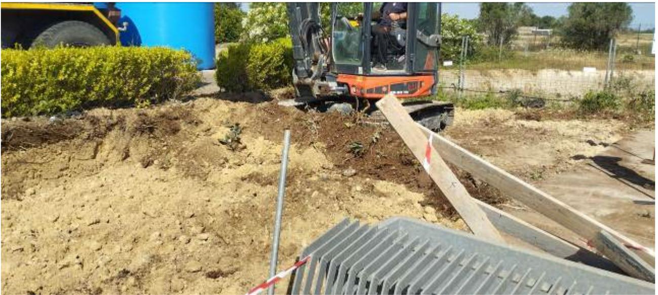
Figure nn.34-35-36-37-38-39 mostrano lo sbancamento area e preparazione della superficie per la livellatura
