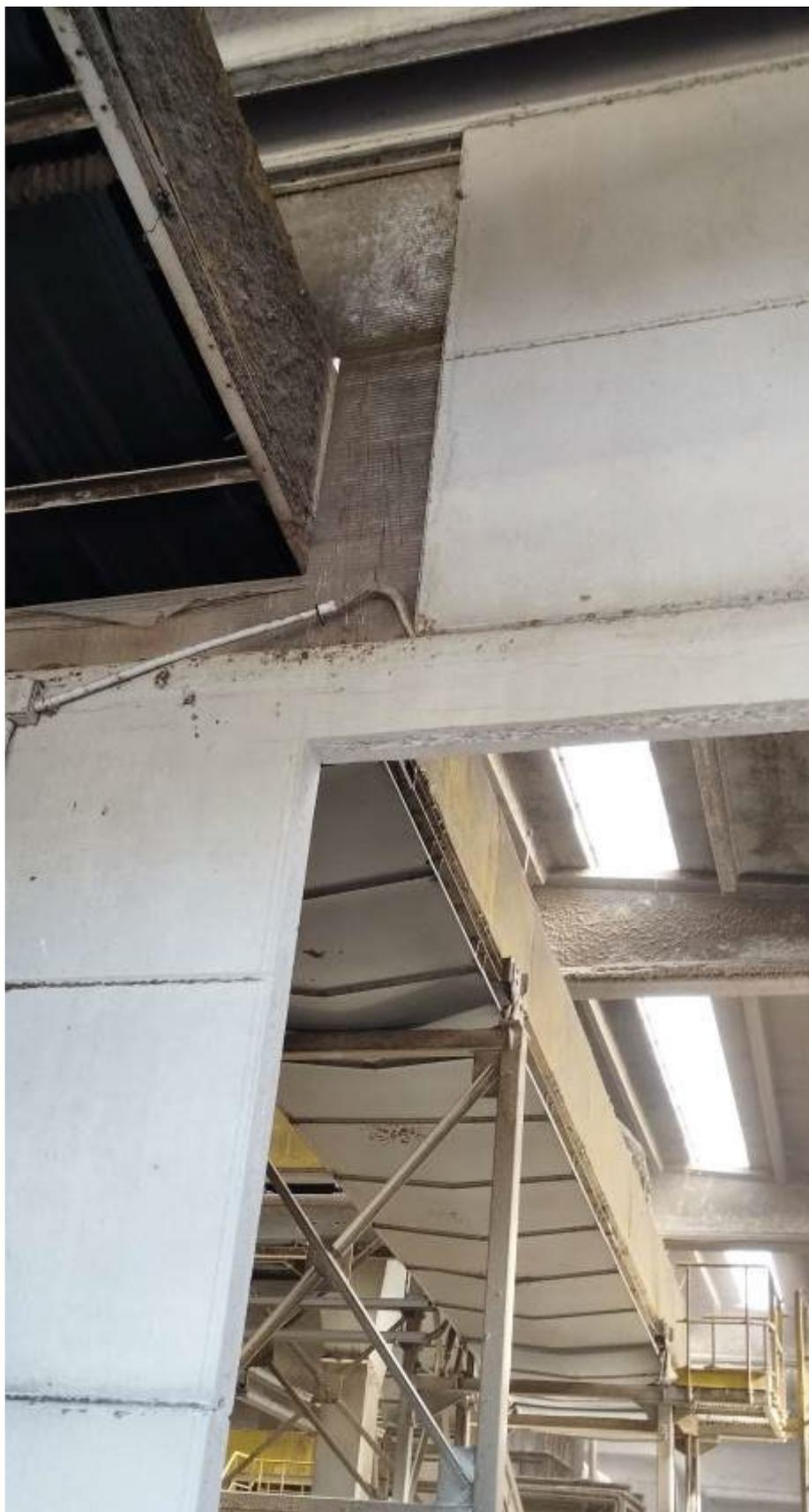
*Figura 29 - finitura profilo parete per il posizionamento del portone*
